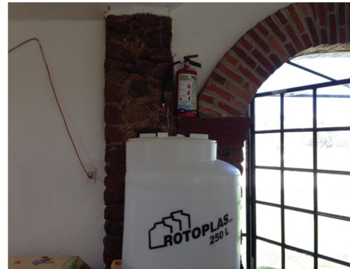
Ubicación del extintor
