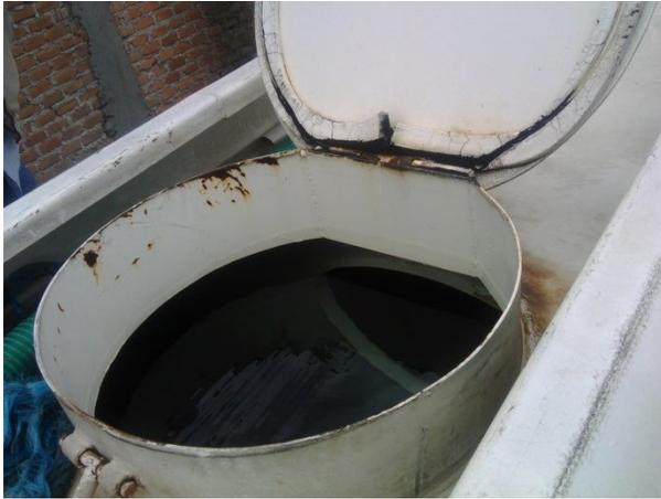
Aquí se muestran las condiciones en las que se encuentra la pintura de la cisterna por la parte de adentro, se aprecia la oxidación y corrosión.
