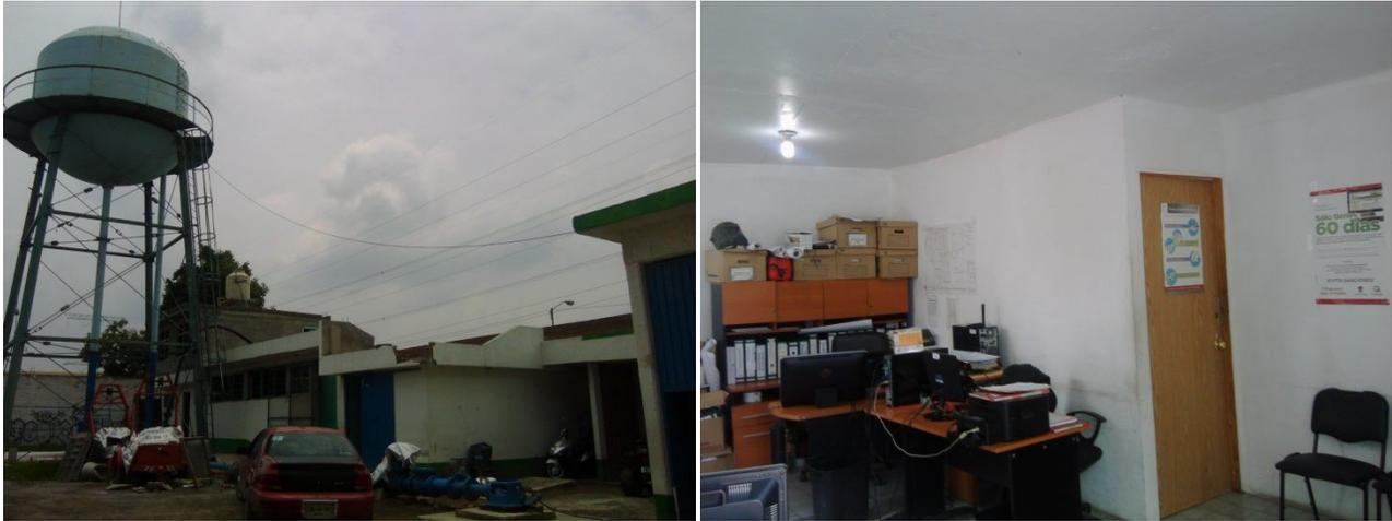
En estas imágenes se observa que el inmueble del OPDAPAS de San Mateo Atenco no tiene extinguidores, ni identificadas las zonas de seguridad, salidas de emergencia, puntos de reunión y rutas de evacuación, además de que cuenta con un tanque elevado de 60,000 litros de agua potable, ya que en un temblor o accidente se puede caer sobre los servidores públicos del Organismo, así como de los contribuyentes que acuden a realizar algún trámite.
