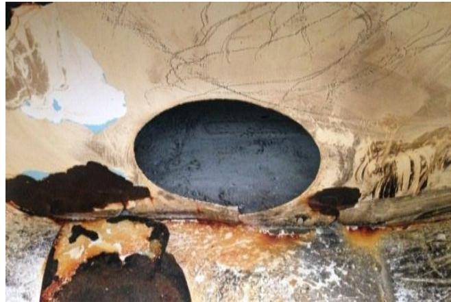
En esta, se observa la oxidación y corrosión de las pipas por dentro.
