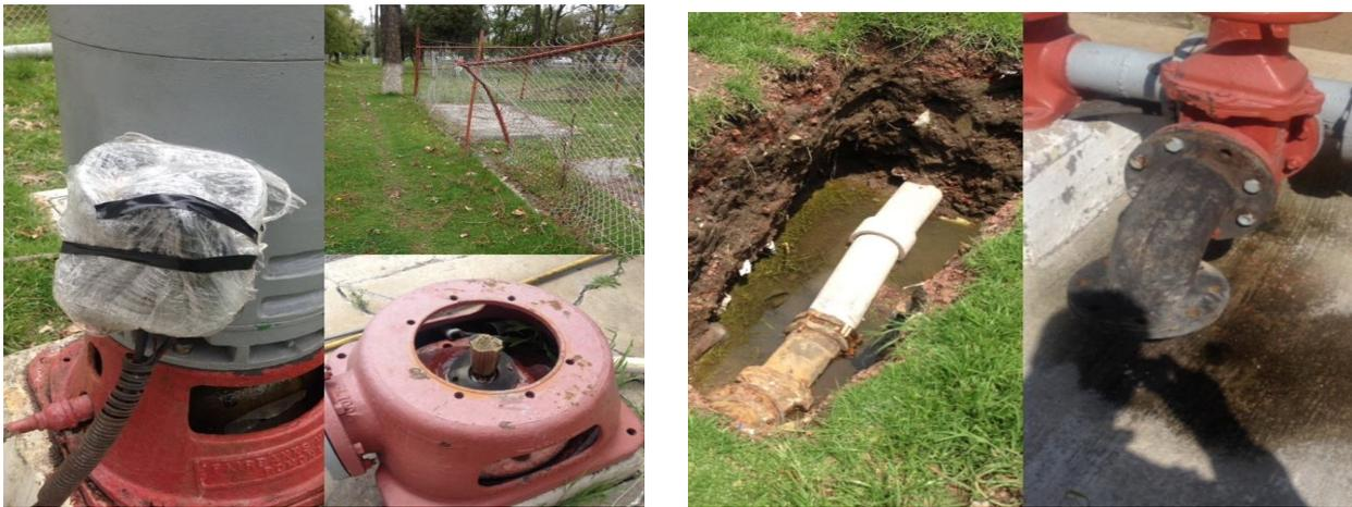
En la primera foto se muestra la falta de mantenimiento a la infraestructura hidráulica, en la segunda existe fuga de agua en la línea principal, la cual se ha reportado en diversas ocasiones sin respuesta alguna.
