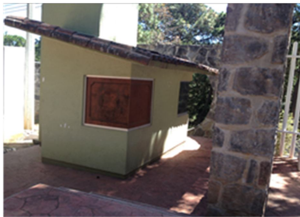
Caseta de vigilancia en la puerta principal, sin personal que controle la entrada y salida de los usuarios.
