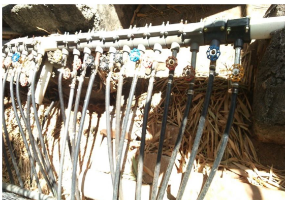
Conexiones de forma provisional
