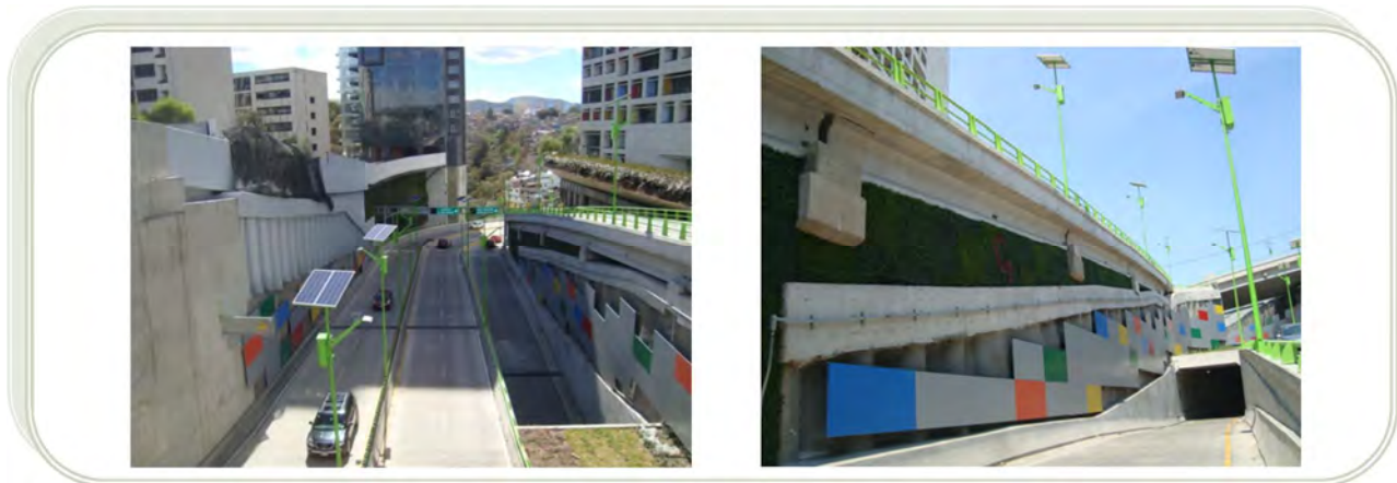
Terminación de la construcción de la vialidad Barranca de Hueyetlaco, municipio de Huixquilucan.
