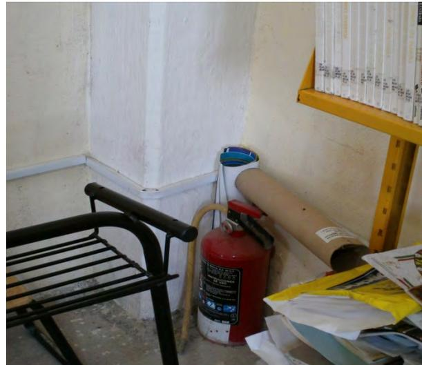
Como se puede observar en los pasillos y escaleras del Ayuntamiento de Axapusco no existe señalización de Protección Civil. Además cuentan con extinguidores con carga que venció desde el mes de septiembre de 2013 y mal colocados sin su señalización correspondiente.
