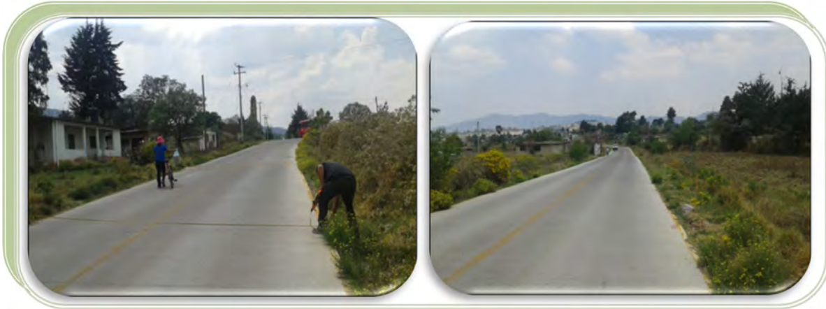
Pavimento hidráulico del estanco a la ex Hacienda Docuay (3ra. Etapa).
