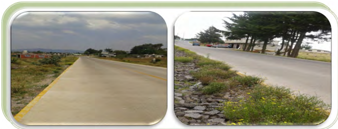
Construcción de pavimento hidráulico en la comunidad de San Juan Tuxtepec.
