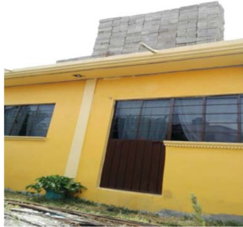
Ampliación sin realizarse y con el material deteriorándose en Totolmajac.
