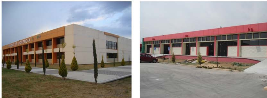
Instalación y rehabilitación del edificio de laboratorios y talleres 2, en la Universidad Politécnica del Valle de México
