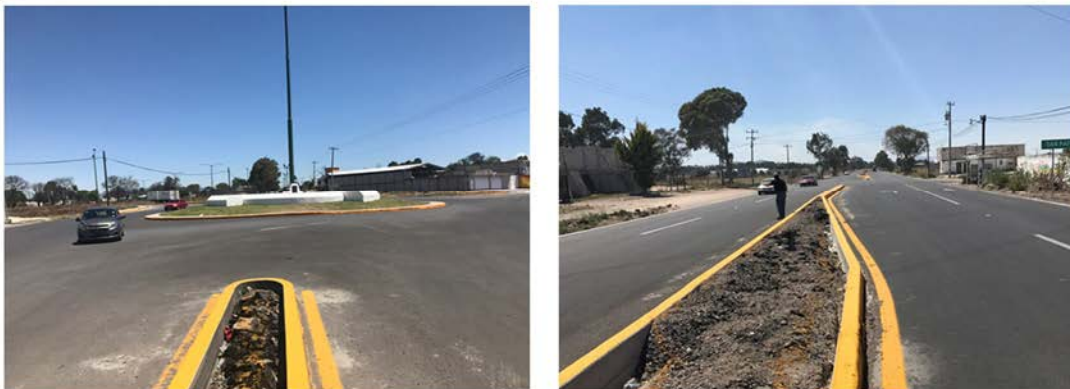
Construcción a cuatro carriles de la carretera Polotitlán-Taxhie. (Municipio de Polotitlán)
