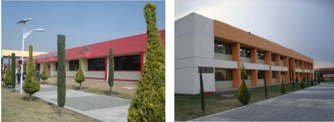
Terminación de construcción de una unidad de docencia, en la Universidad Politécnica del Valle de México
