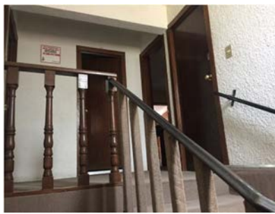
Las imágenes muestran la falta de señalización, salidas de emergencia, extintores y rutas de evacuación.
