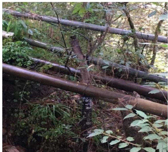
En las fotografías se puede apreciar que los tubos de distribución de agua potable se encuentran sostenidos por maderas de forma
