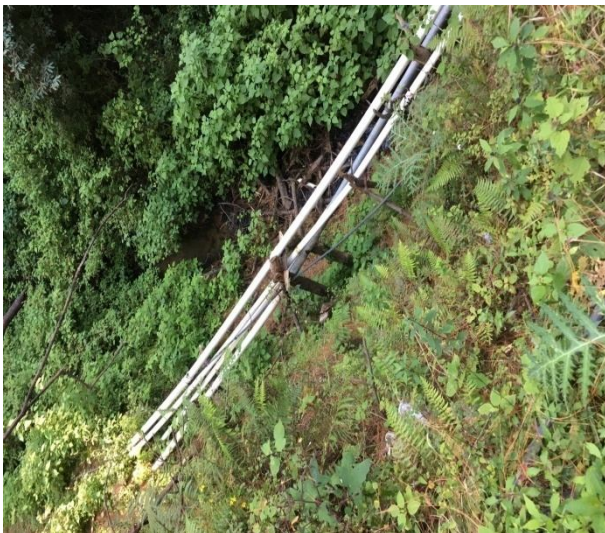
En las fotografías se puede apreciar que los tubos de distribución de agua potable se encuentran sostenidos por maderas de forma
