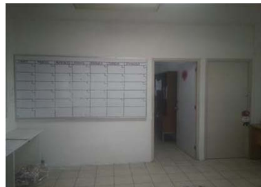
La imagen muestra que las oficinas no cuentan con extintores.
