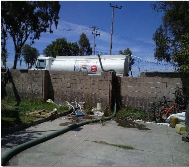
Pipa de agua particular llenando su tanque en la garza del pozo Santa Elena, la cual no está rotulada conforme a la normatividad vigente en la materia, de igual forma no cuenta con bitácora de registro.
