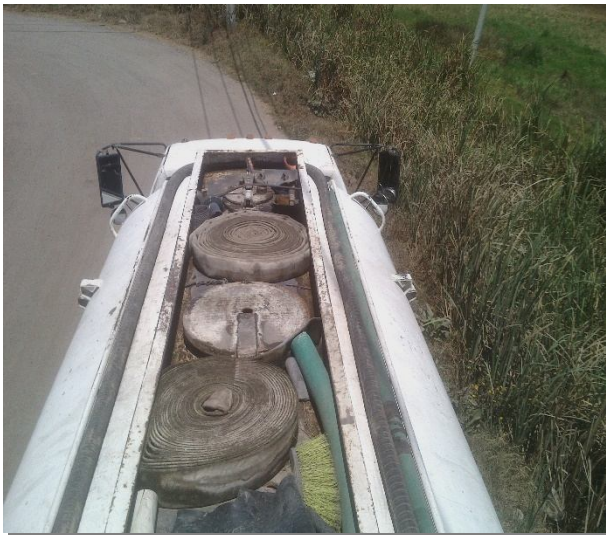
Aquí se aprecia las condiciones de higiene en las que se encuentran las tapas de la cisterna de la pipa del Ayuntamiento de Cuautitlán.
