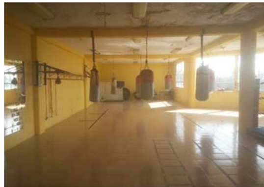
No cuenta con las medidas de seguridad el Área de Box.
