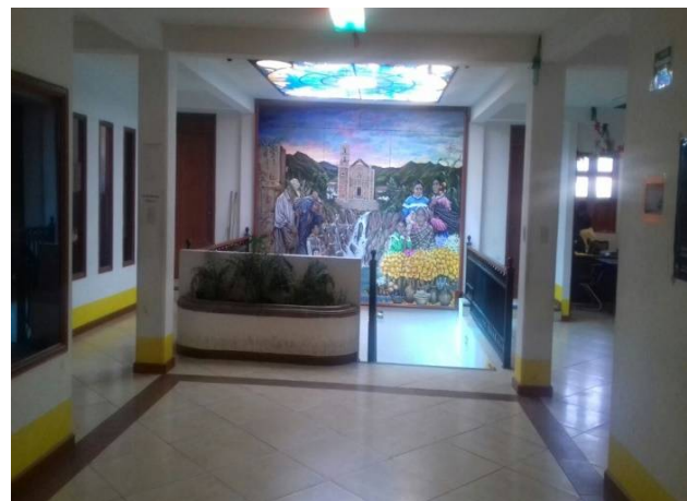
Falta de extintores y señalización conforme a la Norma NOM-003-SEGOB-2011, Señales y Avisos para Protección Civil – Colores, Formas y Símbolos a Utilizar.
