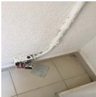
Instalaciones eléctricas en descuido y a la vista de los usuarios
