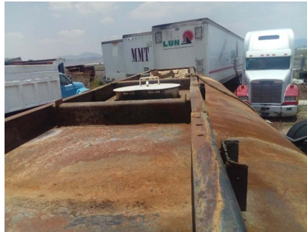
La entrada superior de la pipa cisterna 2 se encuentra oxidada y en mal estado.
