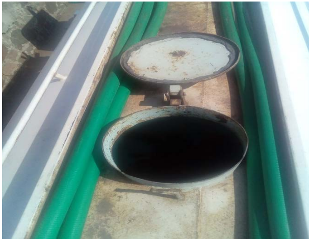
La entrada superior de la pipa cisterna 1 se encuentra oxidada y en mal estado.
