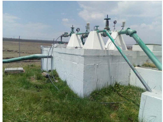
Existe vegetación alrededor del depósito de agua.
