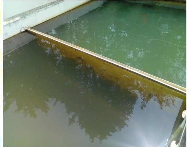
Las paredes-filtro requieren limpieza.
