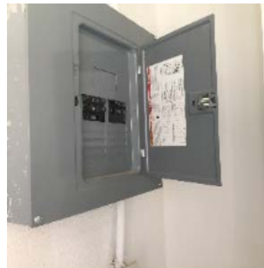
Instalaciones eléctricas en descuido y a la vista de los usuarios
