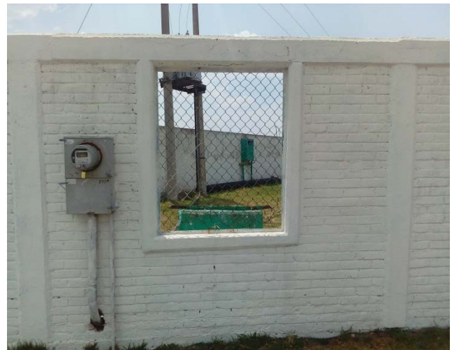
La cerca de la "ventana" se encuentra en malas condiciones, lo que no asegura el acceso al pozo por parte de personas ajenas.
