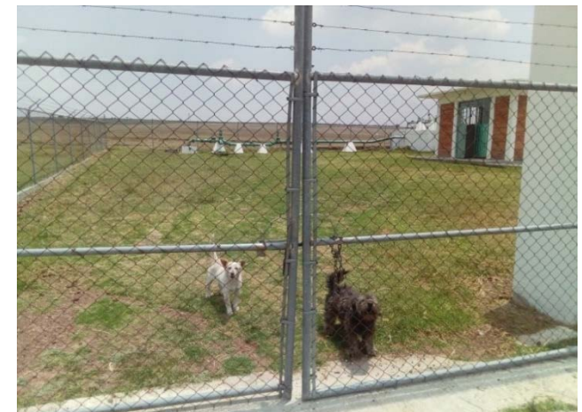
Dos perros fueron encontrados dentro de las instalaciones y la falta de mantenimiento podría ocasionar la contaminación del agua.
