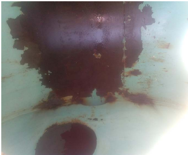
Interior de pipa cisterna 1 con oxidación y corrosión.
