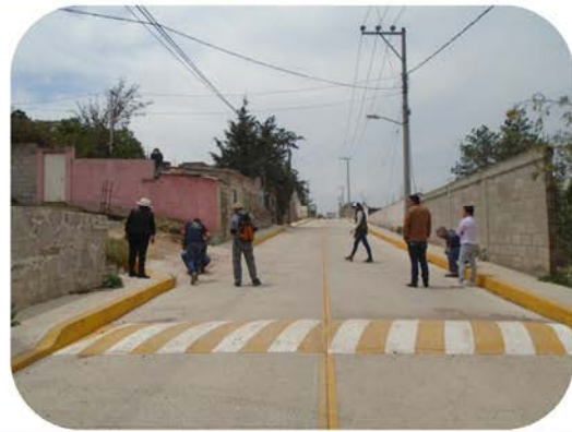
Rehabilitación con concreto hidráulico de calle los Pinos.
