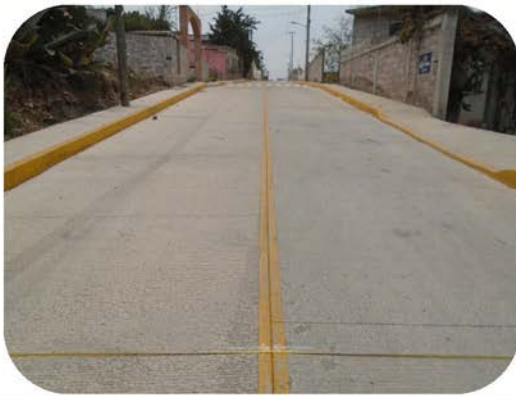
Rehabilitación con concreto hidráulico de calle los Pinos.
