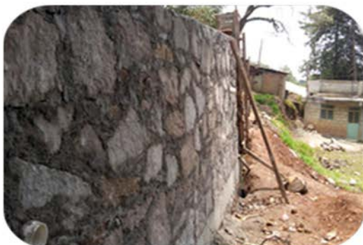
Construcción de muro de contención en Av. de los Maestros primera etapa.
