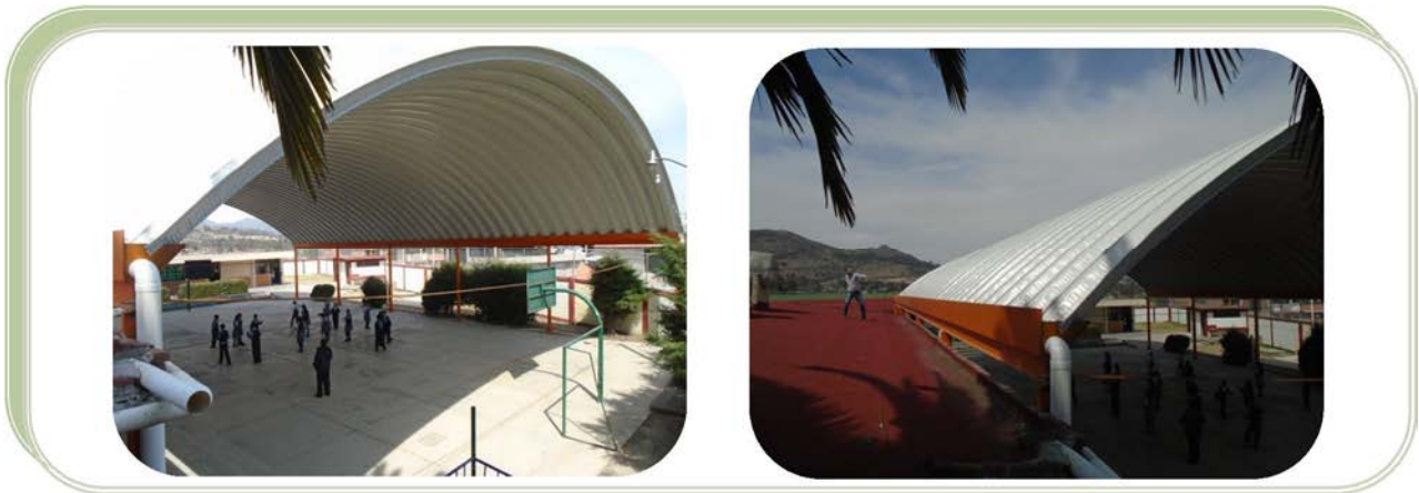
Construcción de techo Esc. Prim. Ignacio Manuel Altamirano.
