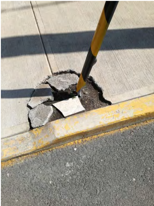
Rutura de banqueta para instalar soporte.
