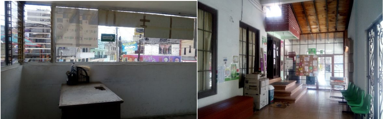
Oficina de la Dirección de Protección Civil y entrada a las oficinas de Tesorería y Catastro las cuales no cuentan con señalizaciones y extintores.
