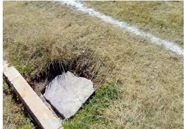
Existe un orificio junto a la cancha de fútbol con barillas expuestas hacia los jugadores lo cual representa un riesgo.
