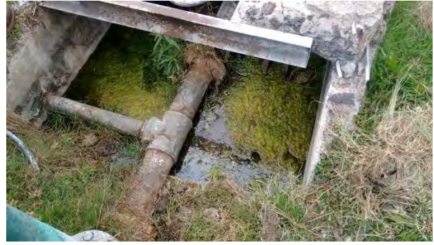
Líneas de agua inundadas, provocando su oxidación.
