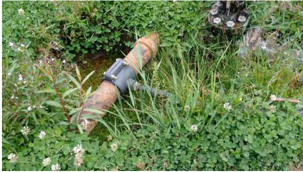
Líneas de agua inundadas, provocando su oxidación.
