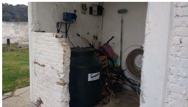
Distinto material almacenado en el lugar donde se encuentra la maquina dosificadora de hipoclorito.
