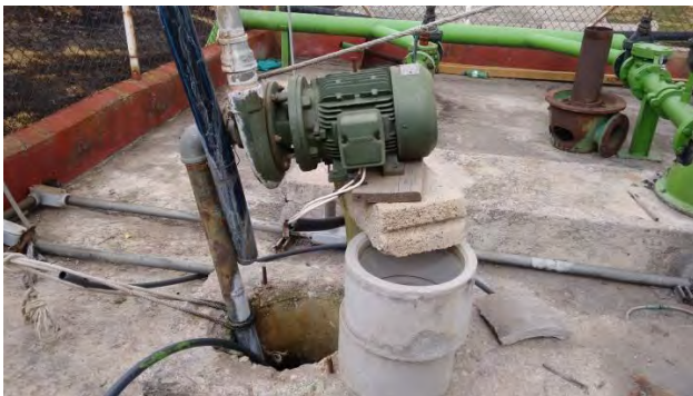
Instalación de bomba improvisada.
