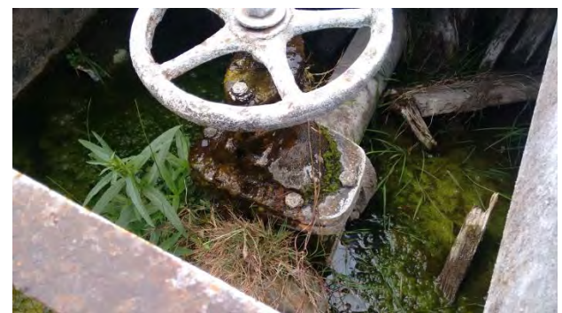
Las válvulas del pozo tienen fugas de agua, provocando su oxidación.
