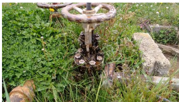
Las válvulas del pozo tienen fugas de agua, provocando su oxidación.
