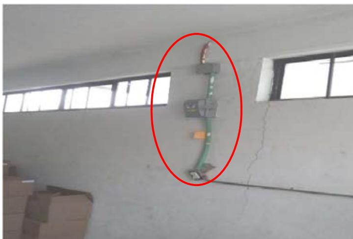
Carencia de señalización de precaución (Advertencia de riesgo eléctrico) para evitar siniestros por la instalación eléctrica.
