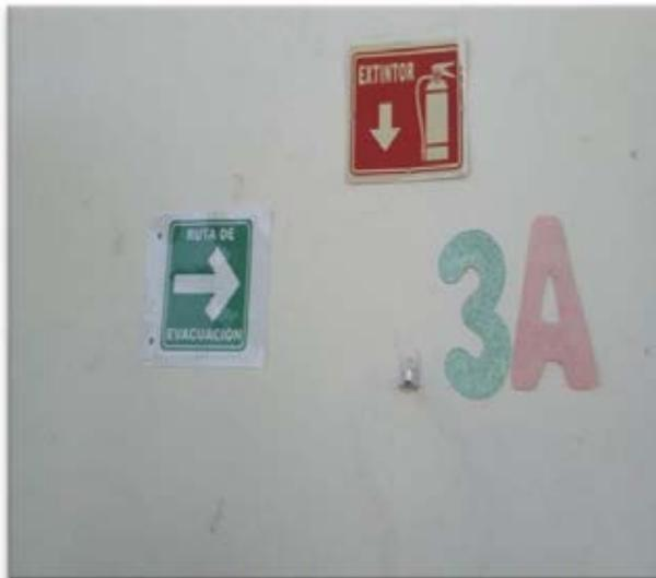
Se observa un extinguidor con su carga vencida, así como un señalamiento de que allí se encuentra un extinguidor, sin embargo el espacio se encuentra vacío.
