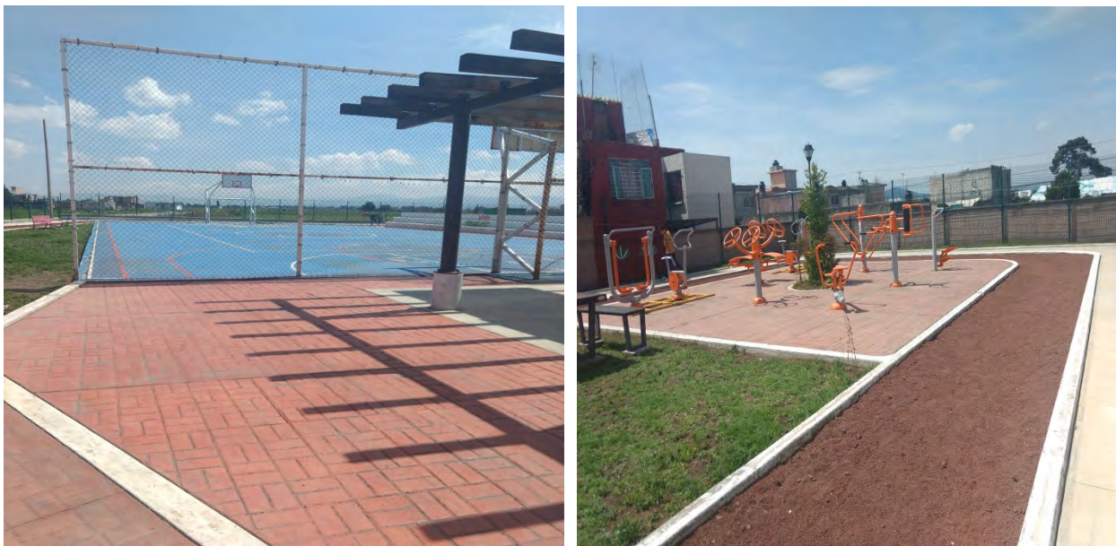
Se observa que el inmueble carece de señalamientos en materia de protección civil.
