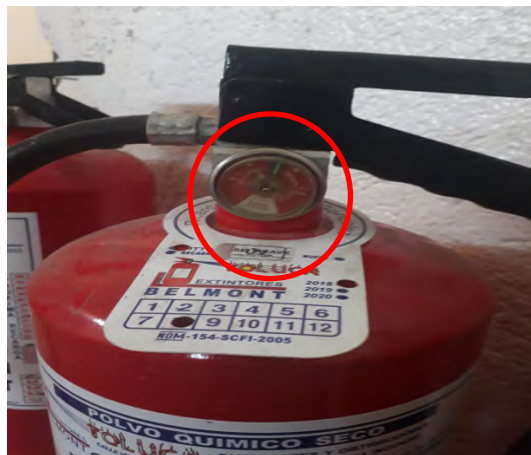
El manómetro señala bajo en presión a pesar de contar con carga reciente
