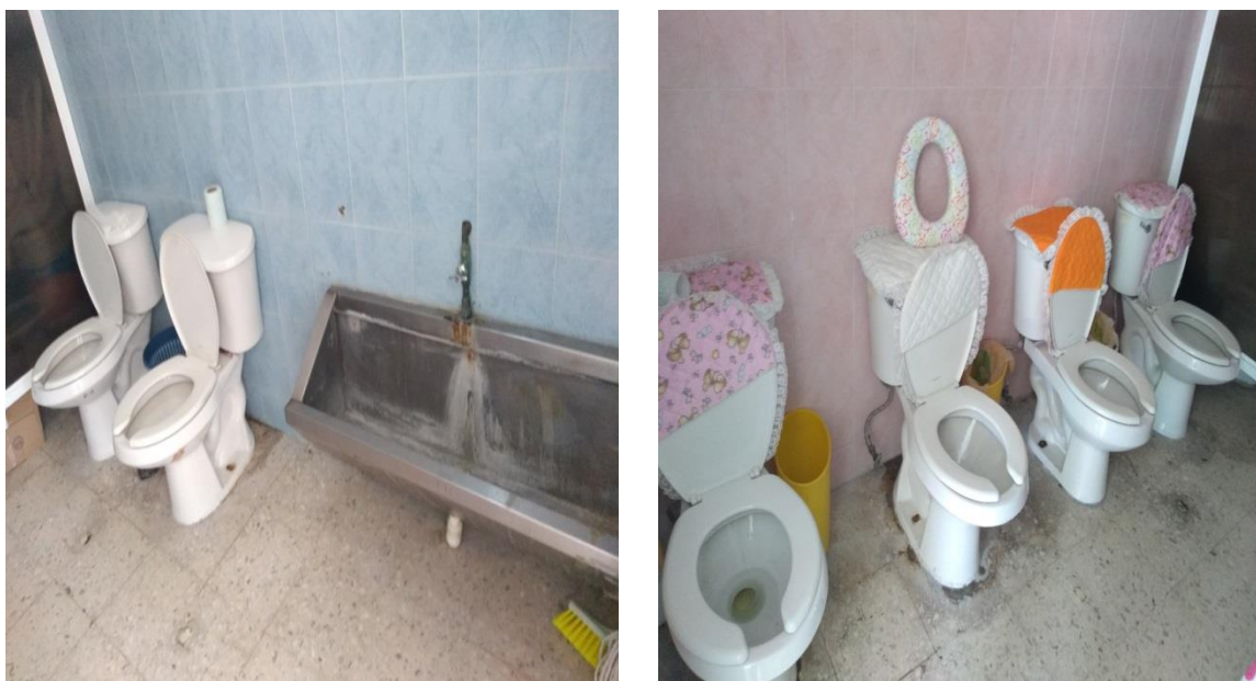
Las imágenes muestran la falta de divisiones en los sanitarios y el migtorio insalubre.
