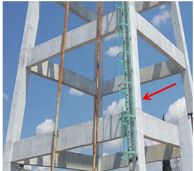
El Tanque no cuenta con barda perimetral, cualquier persona ajena puede subir con ayuda a la escalera de acceso.
