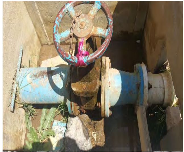
El equipo muestra fugas y oxidación de la misma, poniendo en riesgo la calidad del agua.
