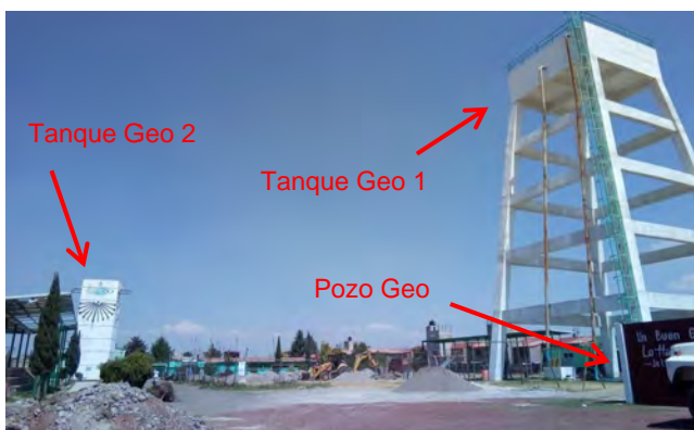
Tanque levado sin barda perimetral que lo proteja.
