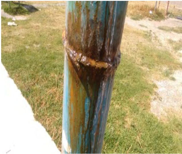
El equipo muestra fugas y oxidación de la misma, poniendo en riesgo la calidad del agua.
