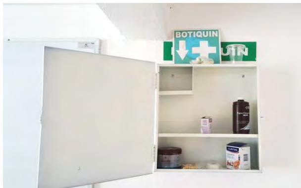
Botiquín de Oficinas Centrales no cuenta con los materiales requeridos por la NOM-030-STPS-2009 y la NOM-005-STPS-1998.
