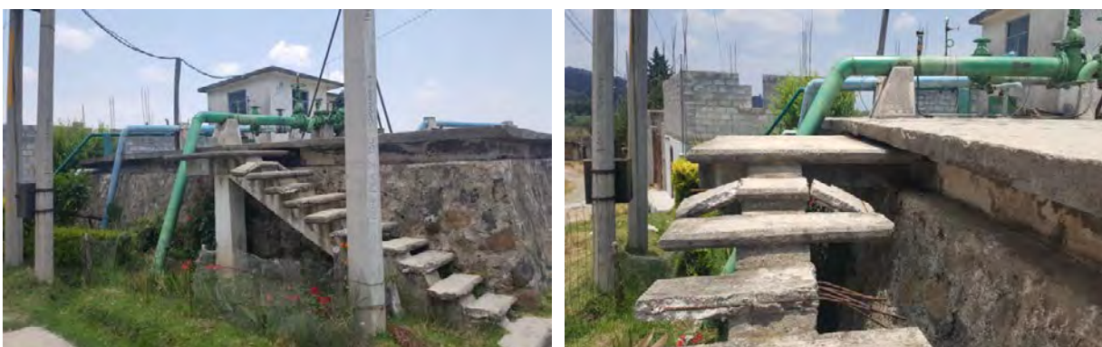
Escaleras de acceso al Pozo de Rebombeo “Semará”.
