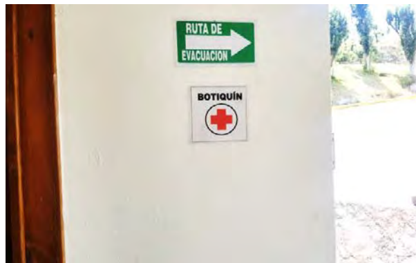
Oficina de la Planta Tratadora cuenta únicamente con una señal de botiquín que no presenta las características requeridas en materia de Protección Civil.
