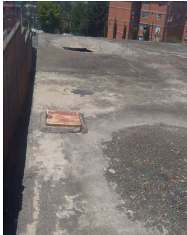
Se observa fauna, barda perimetral en malas condiciones y una perforación en la loza de un tanque, lo cual puede provocar riesgos para el cuidado del agua.
