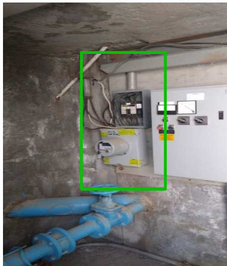
Cableado eléctrico deteriorado y pegado con cinta.
