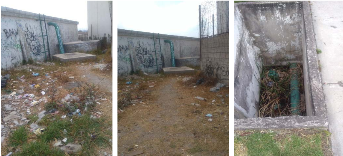
Basura en exceso sin barda perimetral
