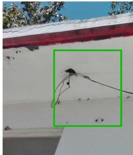
Cableado eléctrico deteriorado y pegado con cinta.
