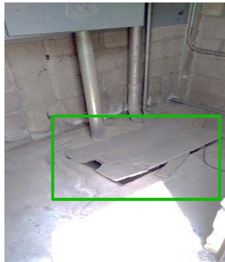
Rebombeo sin señalamientos y tapa provisional.
