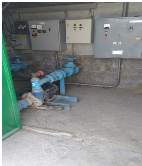
Rebombeo sin señalamientos y tapa provisional.
